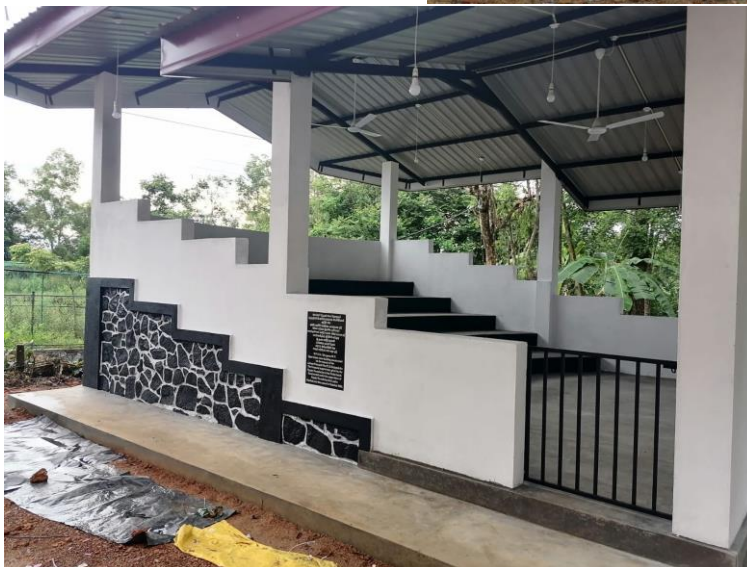
Het pas opgeleverde open klaslokaal van de Diyagama-school
